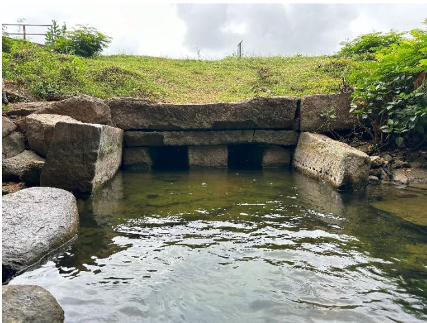
図3 現在も機能しているソロウワ
